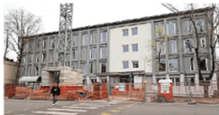
Tolti i ponteggi dalla palazzina ex Asl di viale Montegrappa
